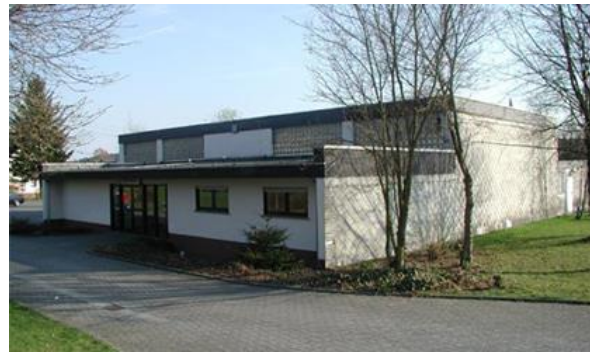
Abbildung 131: Dorfgemeinschaftshalle mit Blick auf den Anbau der 1980er Jahren ohne zeitliche Einordnung Quelle: OBERAHR / WW o.J. d
