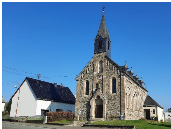
Abbildung 145: Kirche an der Hauptstraße / K 176 / ehemalige B 255
