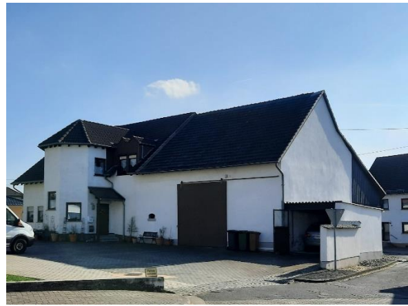
Abbildung 71: Ursprüngliche dörfliche Baustruktur mit Scheune / Stall als Einfirsthaus II
