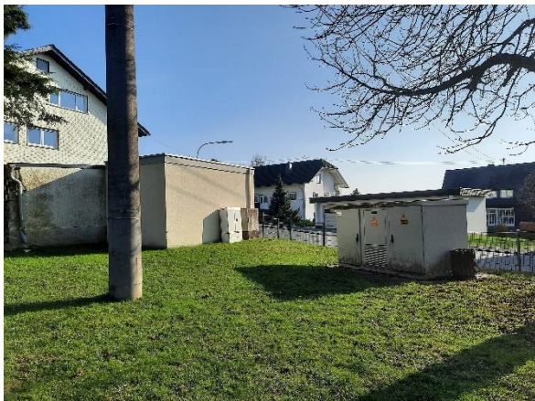
Abbildung 124: Versorgungsgebäude / -kästen der Stromversorgung am Spielplatz mit Blick auf die Straße Auf der Höhe
