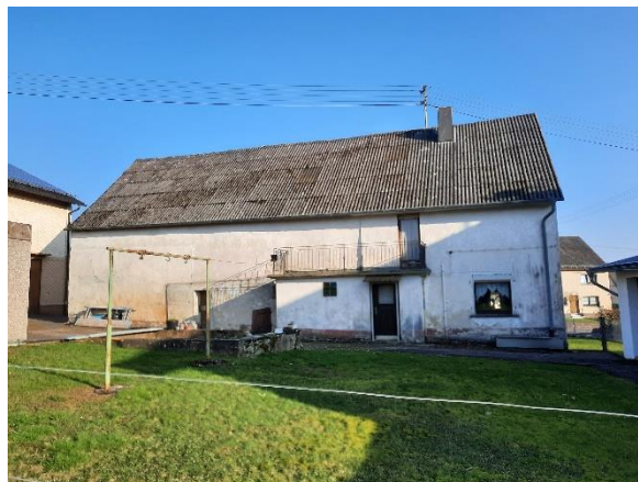
Abbildung 91: Wohngebäude mit Stall / Scheune mit Verschönerungs- / Sanierungsbedarf an der Hauptstraße / K 176 / ehemalige B 255
