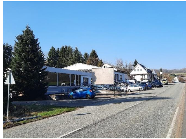
Abbildung 78: Kfz-Werkstatt an der Hauptstraße / K 176 / ehemalige B 255
