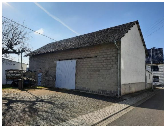
Abbildung 102: Umnutzungspotenzial in der Rotsteiner Straße I
