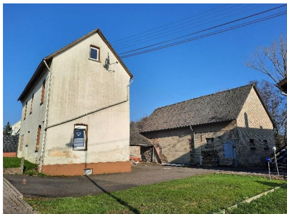
Abbildung 92: Wohn- und Nebengebäude mit Verschönerungs- / Sanierungsbedarf an der Hauptstraße / K 176 / ehemalige B 255
