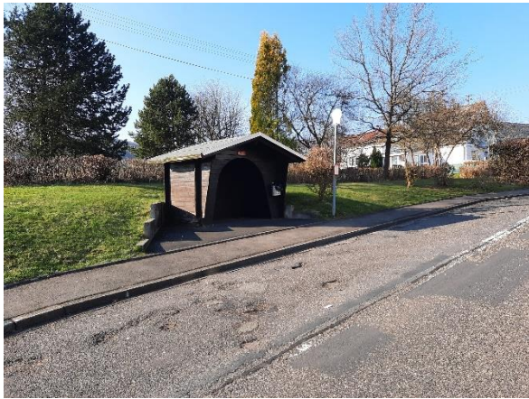
Abbildung 161: Bushaltestelle an der Hauptstraße / K 176 / ehemalige B 255 auf der Seite der Dorfgemeinschaftshalle mit Wartehäuschen
