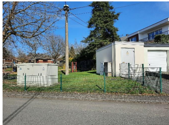
Abbildung 125: Versorgungsgebäude / -kästen der Stromversorgung am Spielplatz mit Blick auf den Spielplatz
