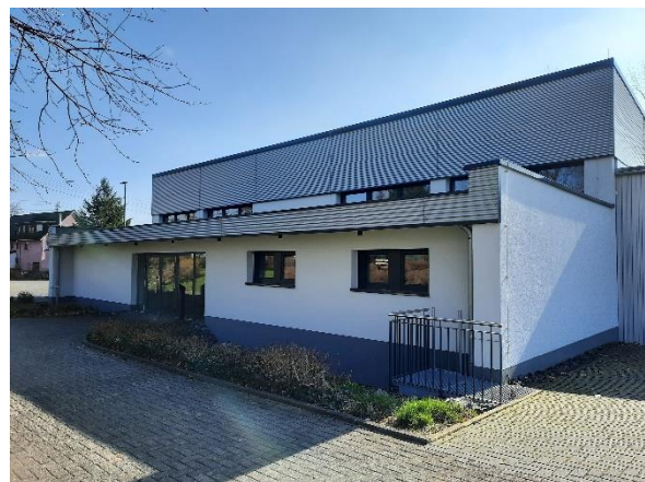
Abbildung 133: Sanierte Dorfgemeinschaftshalle mit Blick auf den Anbau der 1980er Jahre in 2024
