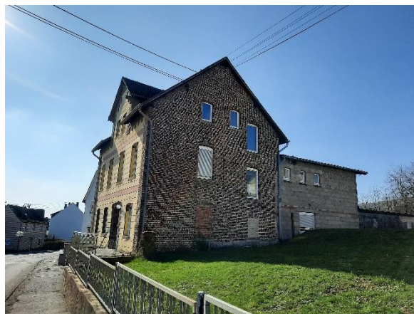
Abbildung 69: Sichtmauerwerk in Ziegelbackstein und verkleidetes Mauerwerk
