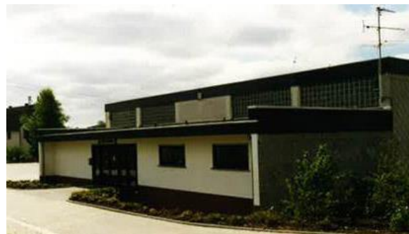
Abbildung 129: Dorfgemeinschaftshalle mit Blick auf den damals neuen Anbau in den 1980er Jahren Quelle: OBERAHR / WW o.J. d
