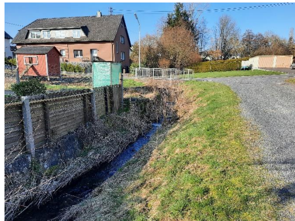
Abbildung 27: Ahrbach südlich der Brunnenstraße
