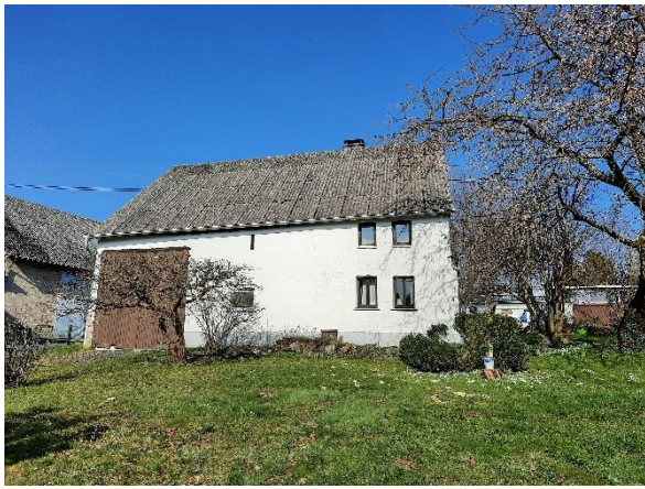
Abbildung 70: Ursprüngliche dörfliche Baustruktur mit Scheune / Stall als Einfirsthaus I
