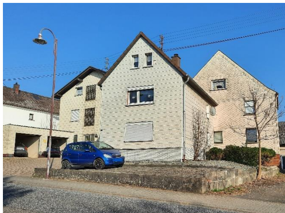
Abbildung 90: Drei Wohngebäude mit Verschönerungs- / Sanierungsbedarf an der Hauptstraße / K 176 / ehemalige B 255
