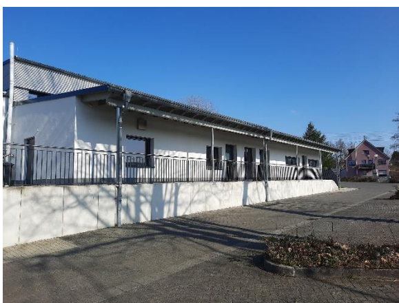
Abbildung 134: Sanierte Dorfgemeinschaftshalle mit neuem Anbau in 2024
