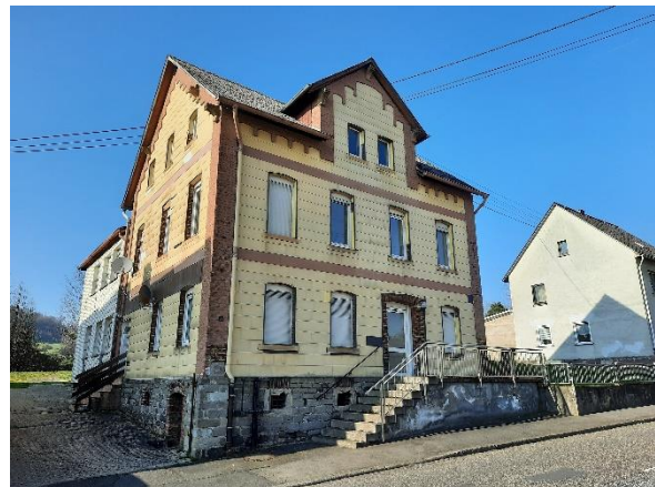
Abbildung 85: Leerstehendes Wohngebäude an der Hauptstraße / K 176 / ehemalige B 255 I
