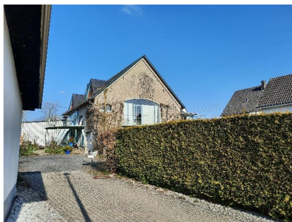
Abbildung 104: Umgenutztes Nebengebäude in der Rotsteiner Straße
