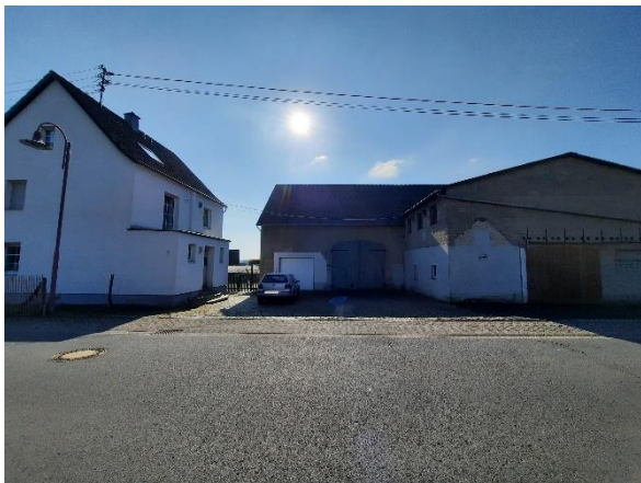
Abbildung 72: Ursprüngliche dörfliche Baustruktur mit Scheune / Stall und Hofsituation I
