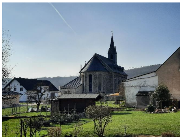
Abbildung 146: Kirche aus der Straße Auf der Höhe betrachtet
