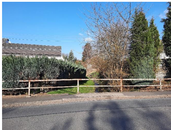
Abbildung 36: Brücke über den Ahrbach an der K 80 Richtung Meudt
