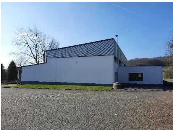
Abbildung 132: Sanierte Dorfgemeinschaftshalle in 2024
