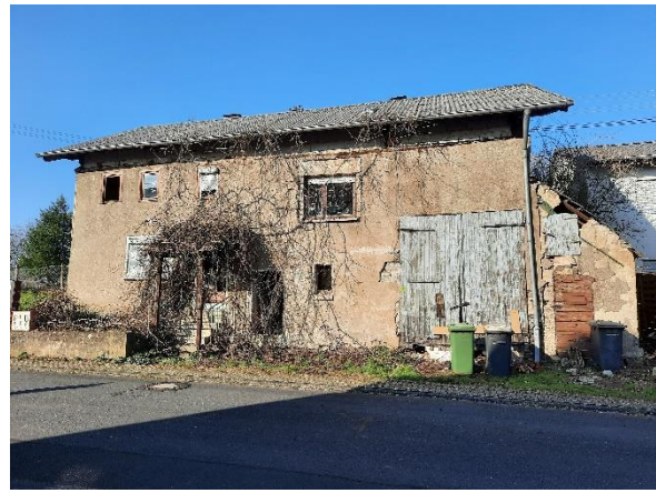
Abbildung 87: Leerstehendes Wohngebäude an der Straße Auf der Höhe
