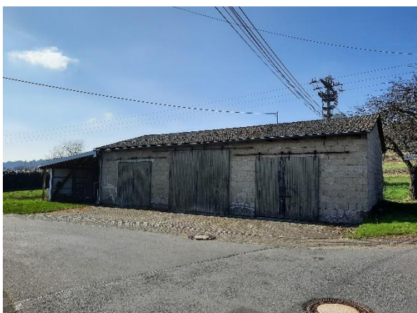
Abbildung 103: Umnutzungspotenzial in der Rotsteiner Straße II
