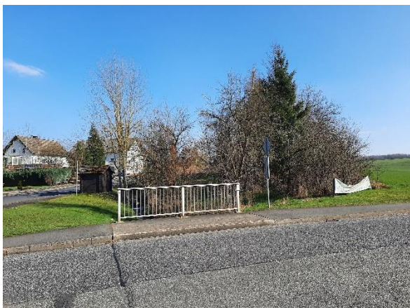
Abbildung 37: Brücke über den Ahrbach an der Hauptstraße / K 176 / ehemalige B 255
